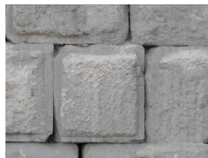
Herodiaanse steen met bies in de Oostelijke Muur. Foto B. Otten in 2010.
